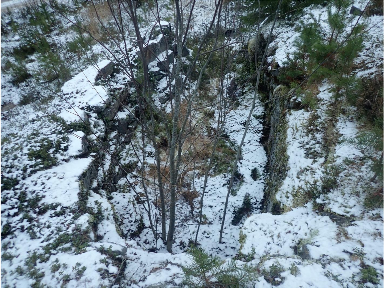
Kuva 46. Kivirakenne yläpuolelta. Kuva: Arttu Tokoi.
